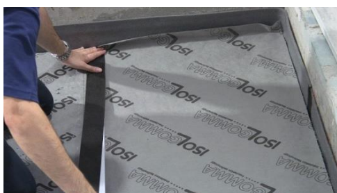
Schutzfolie entfernen und Fugen abdichten
