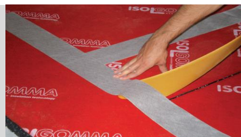
Schutzfolie entfernen und Fugen abdichten
