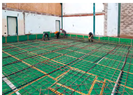
Office building foundation, Romano d'Ezzelino, Vicenza.
