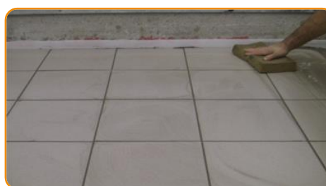
Gdy fuga zacznie twardnieć, można usunąć nadmiar fugi z płytek
