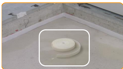
Przymocuj Profile Flat 5 na dolnej krawędzi ścian
