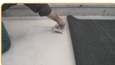
Rozprowadź cienką warstwę kleju na podłodze i przyklej matę Sylcer
