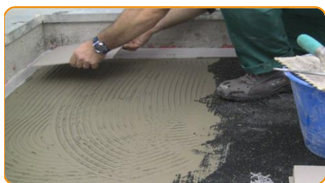
Rozprowadź elastyczny klej do płytek. Ułóż ceramiczne płytki podłogowe
